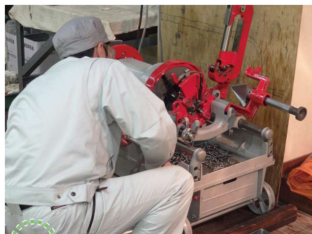
給排水配管の施工
