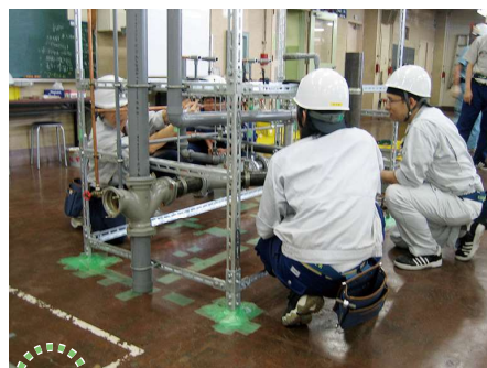
給排水配管の施工
