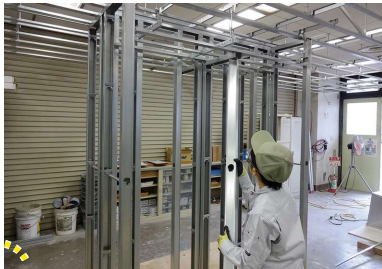
鋼製下地（壁と天井の下地）
