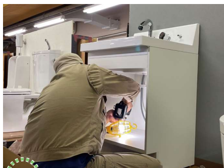
衛生器具の取付け
