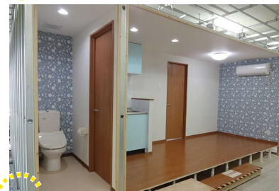
模擬家屋の施工（応用実習）
