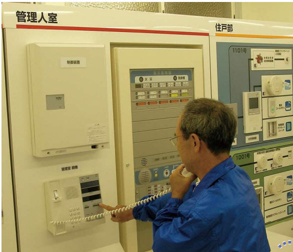
防災機器の操作実習
