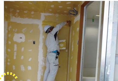
壁の下地処理（パテ処理）
