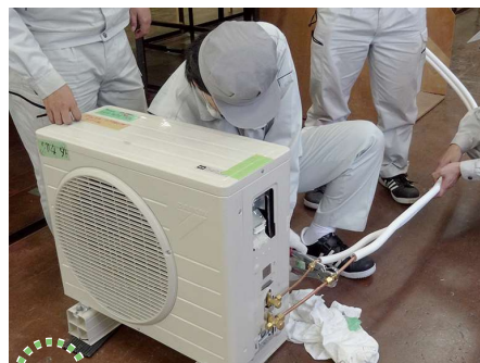
エアコンの取付け
