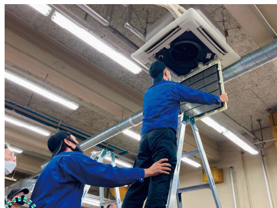
エアコン点検・清掃実習
