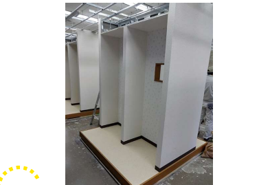
模擬家屋の施工（基礎）
