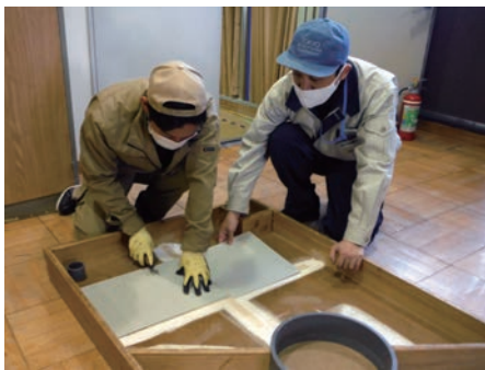
写真④：床仕上げ基礎作業
