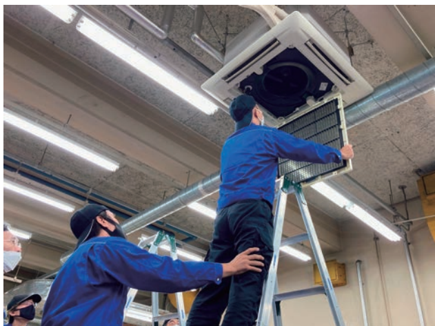
写真①：エアコン点検・清掃実習
