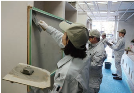
写真⑦：左官・タイル張り
