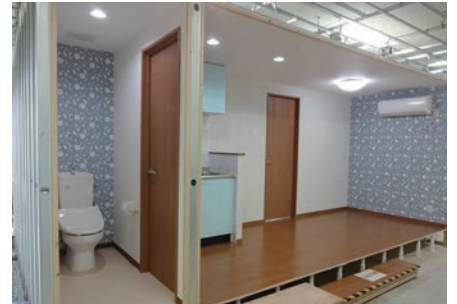
写真⑨：模擬家屋の施工（応用実習）
