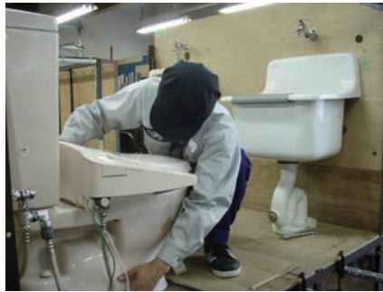
写真②：衛生陶器の取付け
