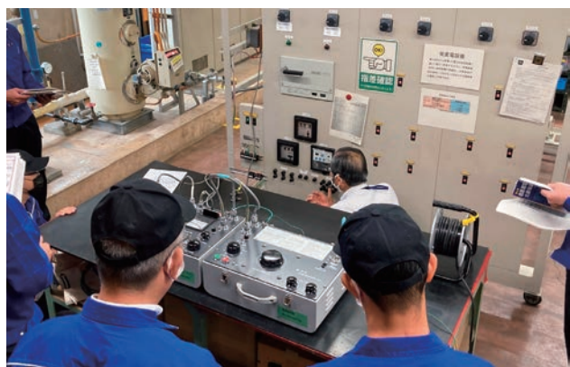
写真③：高圧受変電設備点検実習
