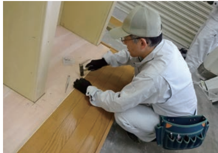
写真⑤：フローリング施工
