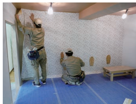
写真③：壁紙張り作業
