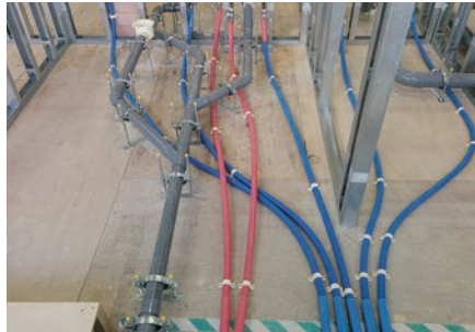
写真⑧：建築設備（配管の施工）
