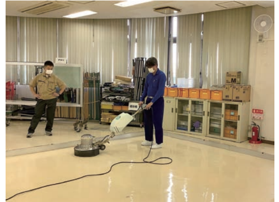
写真④：ポリッシャーの基本操作作業
