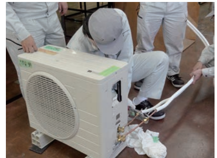
写真⑥：エアコンの取付け
