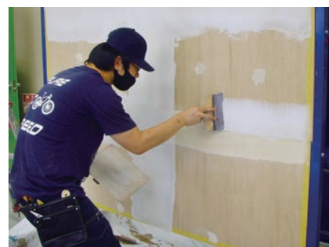
建築塗装実習（内装壁の下地処理） 塗装前の下地作業として、パテ作業をしています。
