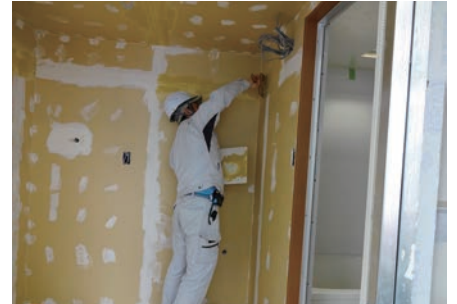
写真③：壁の下地処理（パテ処理）
