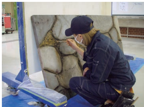
特殊塗装（デコラティブペイント） 石垣風に仕上げています。
