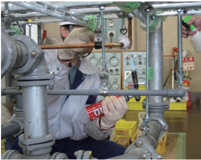
写真①：給排水配管の施工
