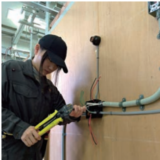
写真④：結線作業
