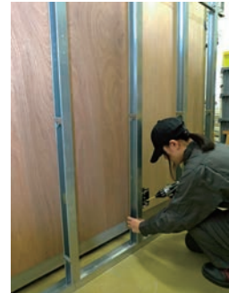
写真⑥：LGS にボックス設置
