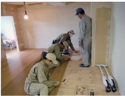
写真⑤：床仕上げ基礎作業
