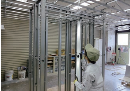
写真①：鋼製下地（壁と天井の下地）
