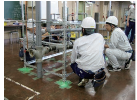
写真③：給排水配管の施工
