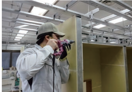
写真②：ボード張り
