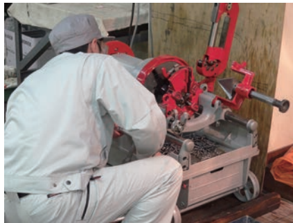
写真⑤：給排水配管の施工
