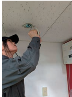
写真⑤：天井に照明器具を設置
