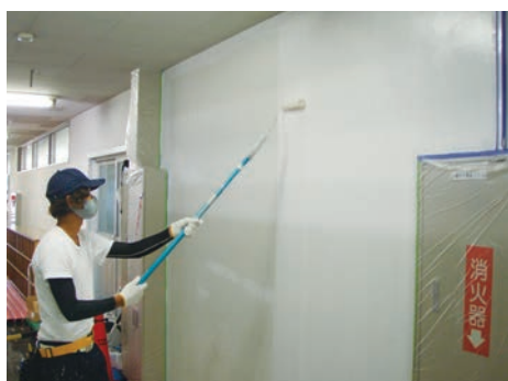
建築塗装実習（壁の塗装） ローラーブラシで壁の上塗り塗装作業をしています。
