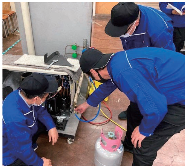
写真②：家庭用エアコン点検等実習
