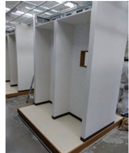
写真⑥：模擬家屋の施工（基礎）
