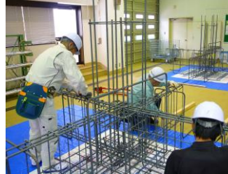
鉄筋施工作業
