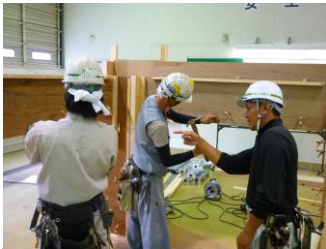
型枠施工作業
