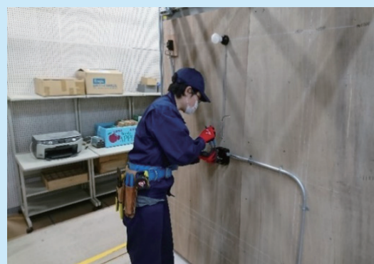
電気工事作業
