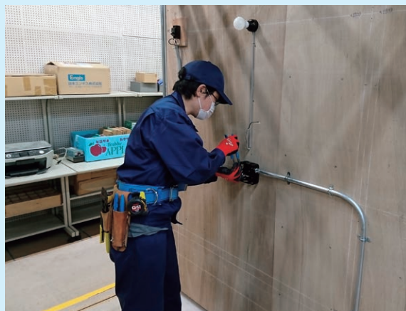
電気工事作業
