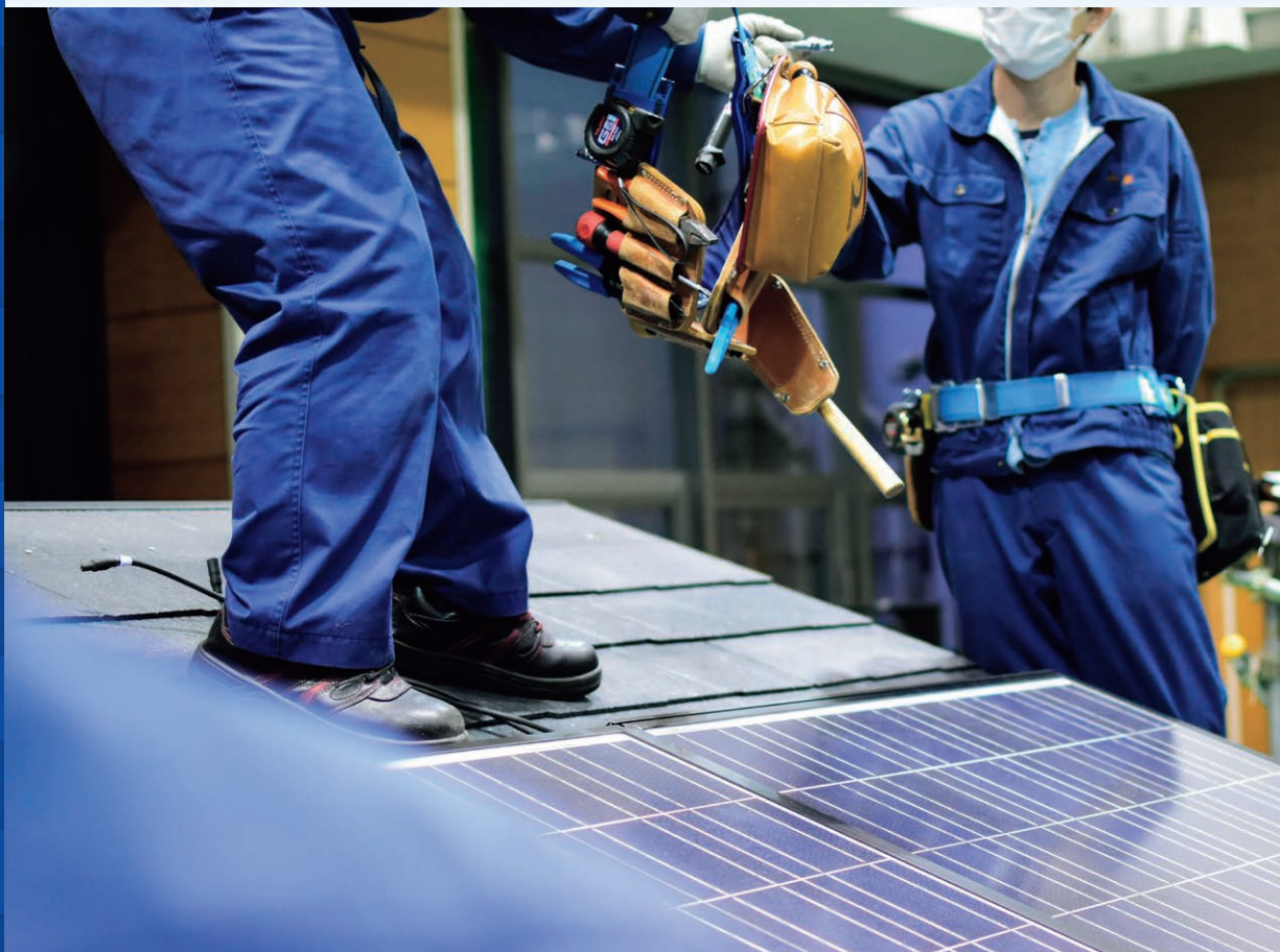
模擬屋根における太陽光発電パネル設置作業
