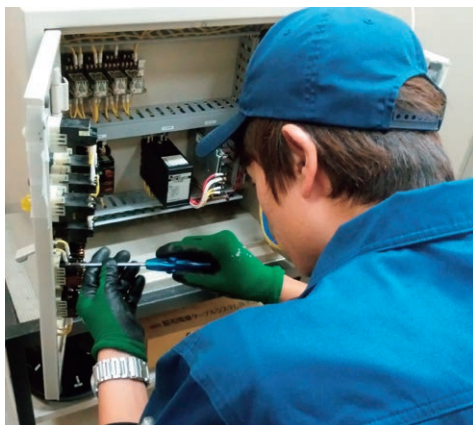
制御盤配線実習
