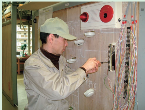
自動火災報知設備工事実習
