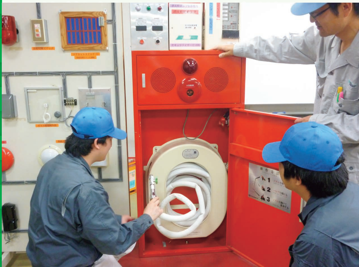
防災設備の点検作業の様子
