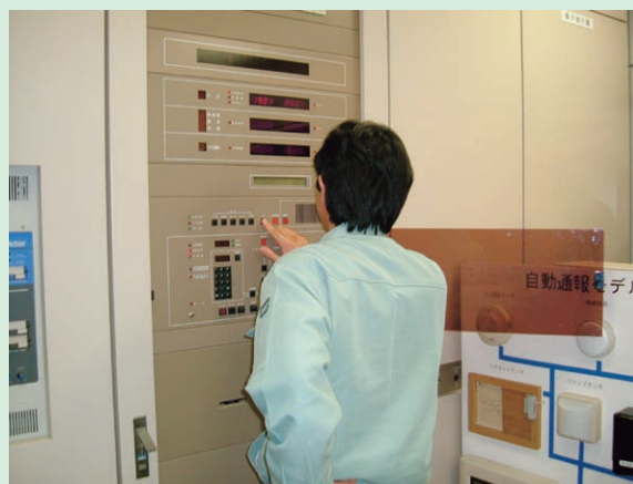
火災報知設備点検実習
