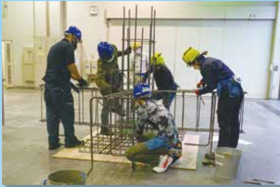
鉄筋施工実習
