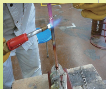
冷媒配管溶接
