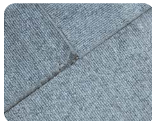
カーペットのめくれを修繕
